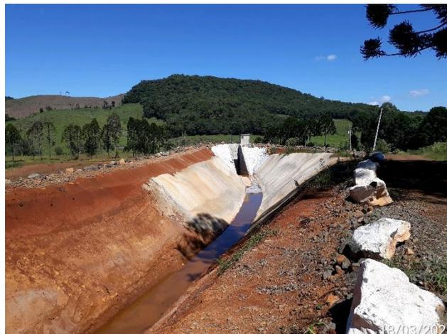
Figura 67: Câmara de carga da CGH Enxadrista.
